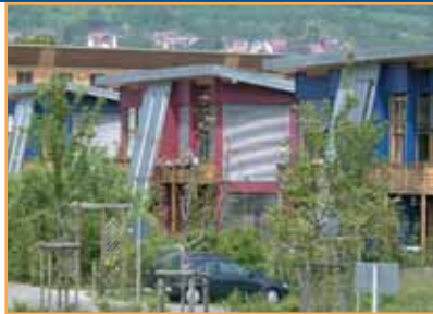
Maisons passives à Lörach Stetten
