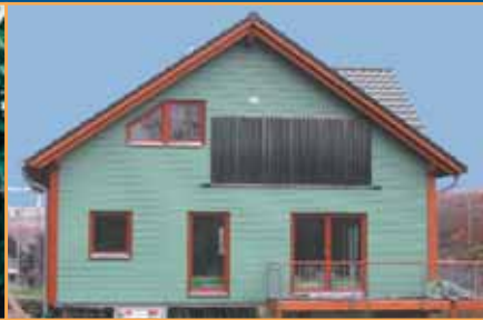
Maison uni-familiale avec montage sur façade
