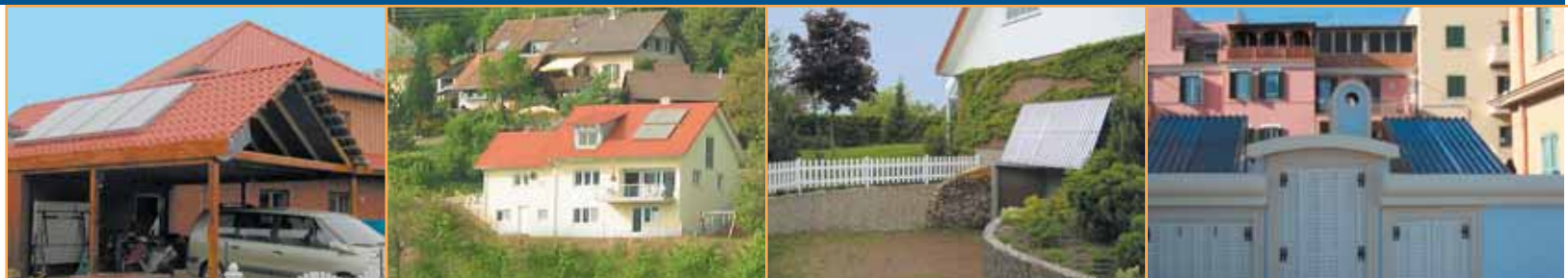
Des variantes de montage - sur toiture inclinée, sur façade, sur toiture plate
