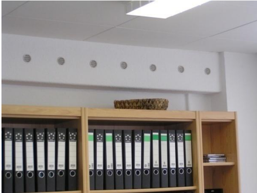
grille d'arrivée d'air dans conduit-iso
