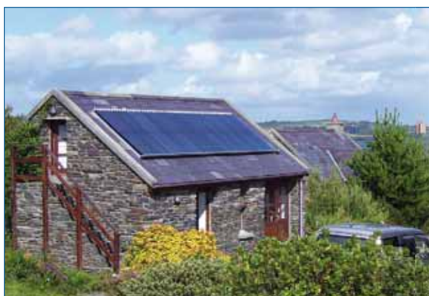
Installation à un champ de capteurs, toiture en pente en parallèle (avec fixation de toiture spéciale)
